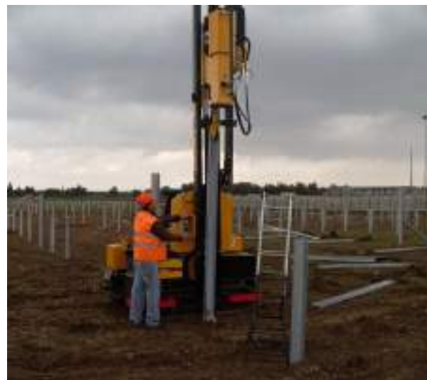
Illustration 62: Exemple de fondation type pieux
