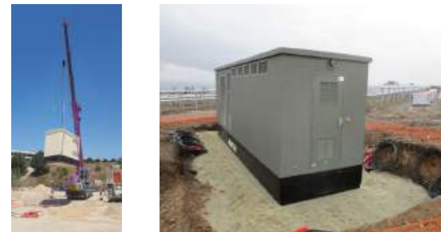
Illustration 73: Installation d'un poste électrique
