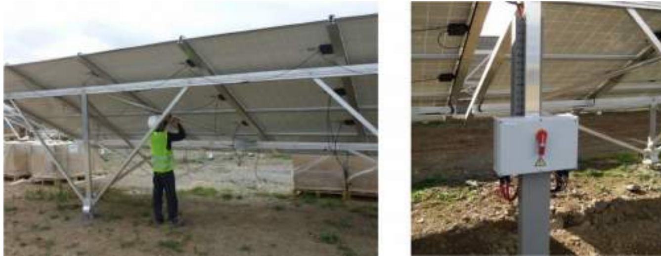
Illustration 74: Réalisation des connexions
