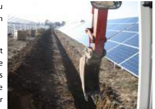
Illustration 72: Exemple de tranchée entre deux tables photovoltaïques
