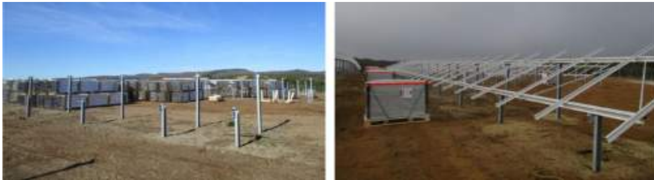
Illustration 70: Assemblage des structures du site
