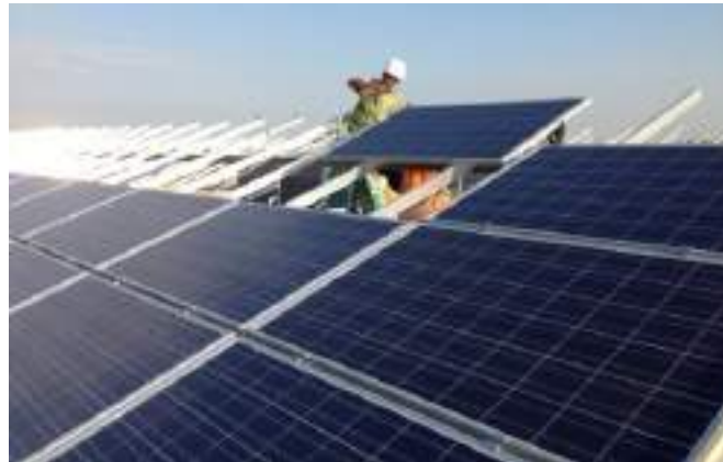
Illustration 71: Exemple de mise en place des panneaux sur les structures
