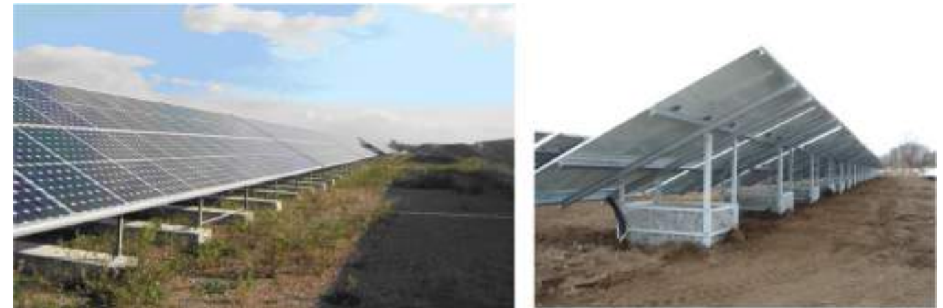
Illustration 63: Exemple de fondations hors sol
